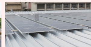
折半屋根の遮熱塗装
