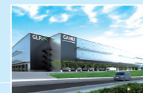
日高流通センター (2025年春 稼働予定)
