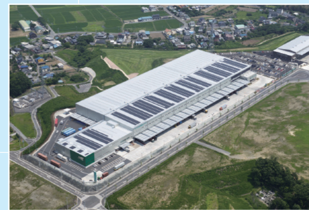
太田流通センター (屋上に太陽光パネルを設置)
