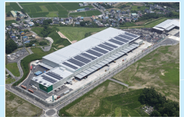
太田流通センター（屋上に太陽光パネルを設置）
